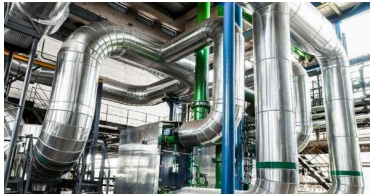
Bọc cách nhiệt cho đường ống hệ thống lạnh
